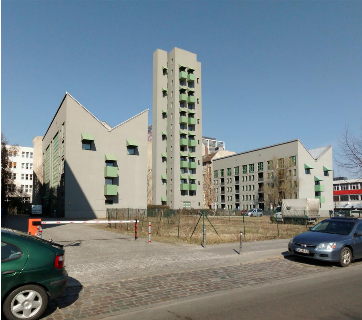
Abb.3: Wohnbebauung mit Atelierturm, John Hejduk, IBA 87
