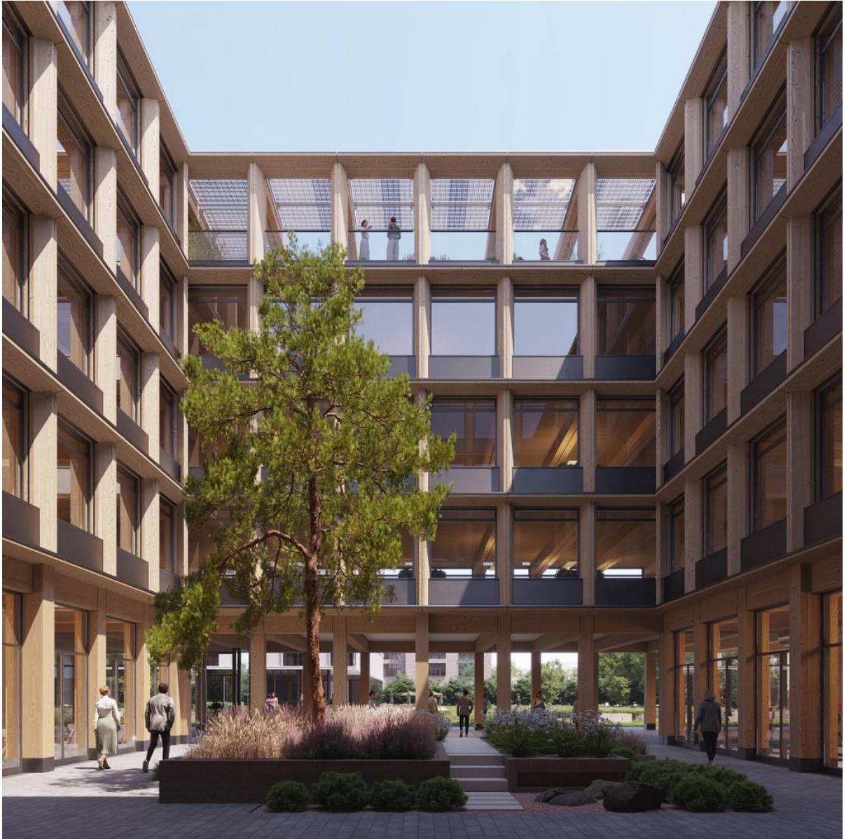
Abb.15: Bürogebäude »ZERO« in Holzmodulbauweise
