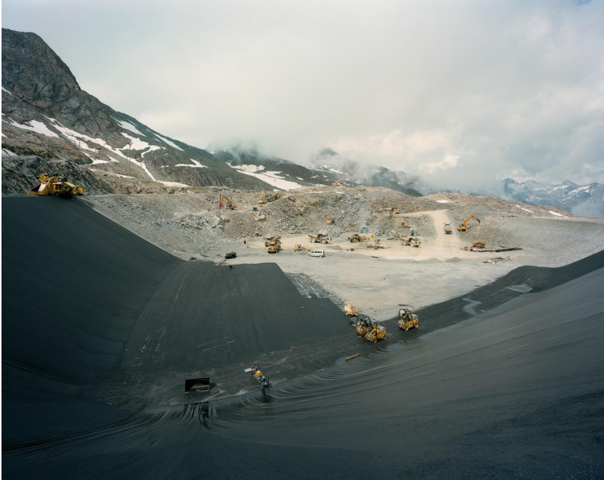
Lois Hechenblaikner, Bau des Speichersees „Panorama“ in Sölden, Fotografie aus der Serie „Berg.Werk“, ca. 2009/10 © Lois Hechenblaikner.
