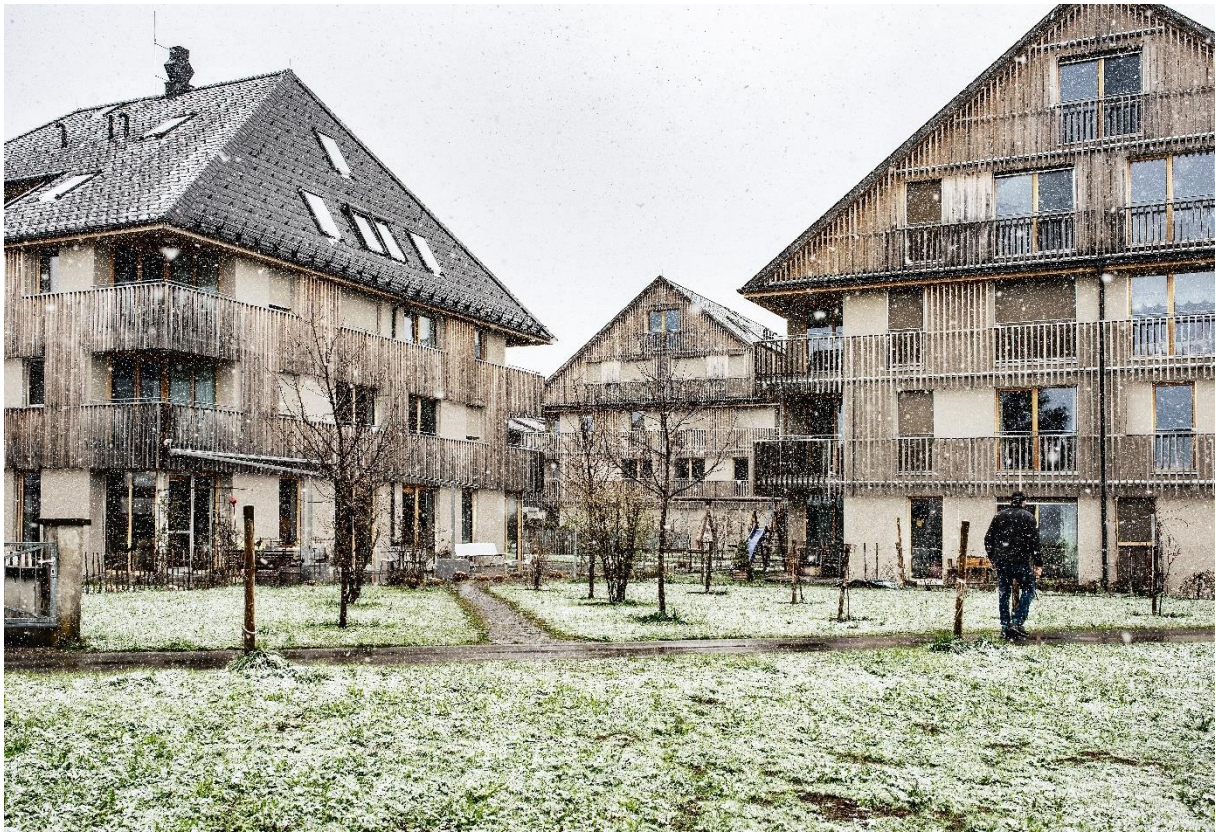
Wohnhausanlage „Wohnen Hof“ in Andelsbuch, Foto: © lippzahnschirm+raneburger
