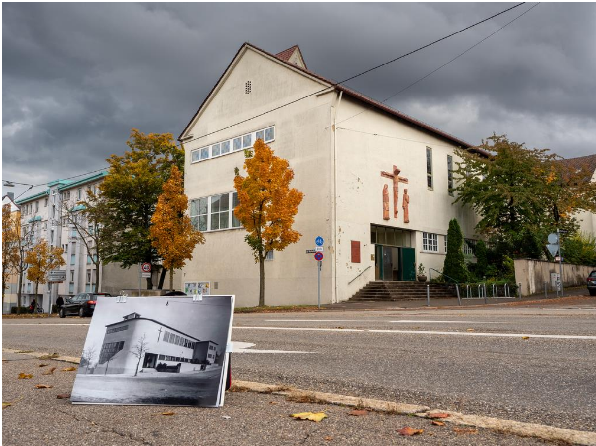
Abb.10: Brenzkirche in Stuttgart: Urzustand 1933 und aktueller Bestand vor dem Umbau
