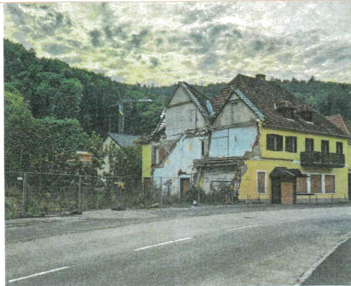
▲ Die Baustelle beim ehemaligen Gasthaus Hintenberger ist derzeit verwaist ist offen, was mit dem Areal weiter geschehen wird.
