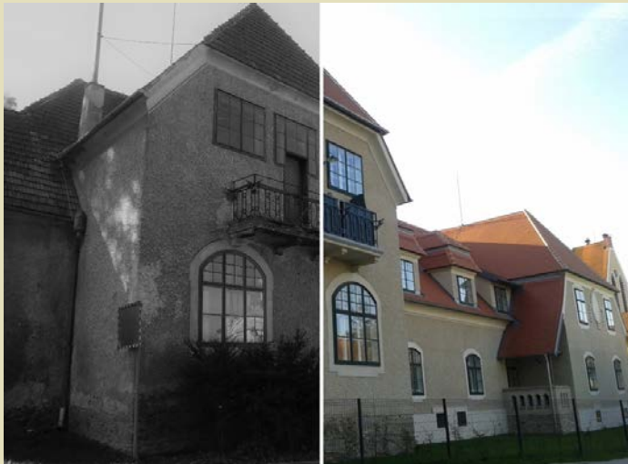
Zum Therapiezentrum saniertes Wohngebäude in Jaidhof
