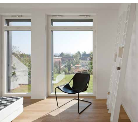
Einseitige Fensterlüftung mittels Oberlichtern Foto: Adam Mørk
